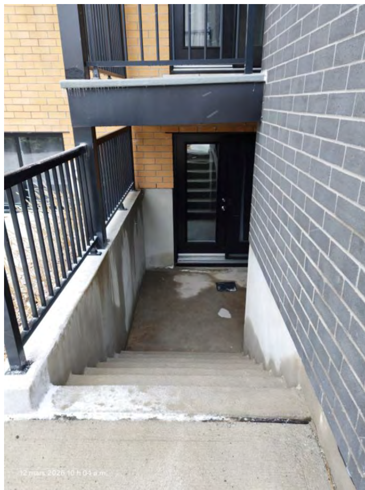
Main courante a ajouter aux descente arriere (5600 & 5700)
