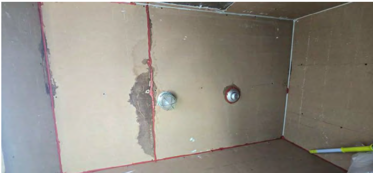
Remise en état du 7-5700 au point #9
