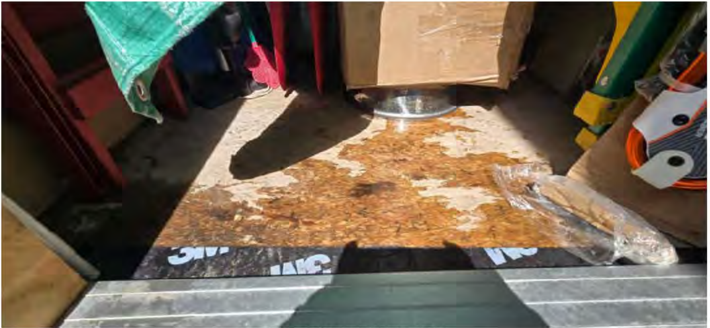
Remise en état du 7-5700 au point #9
