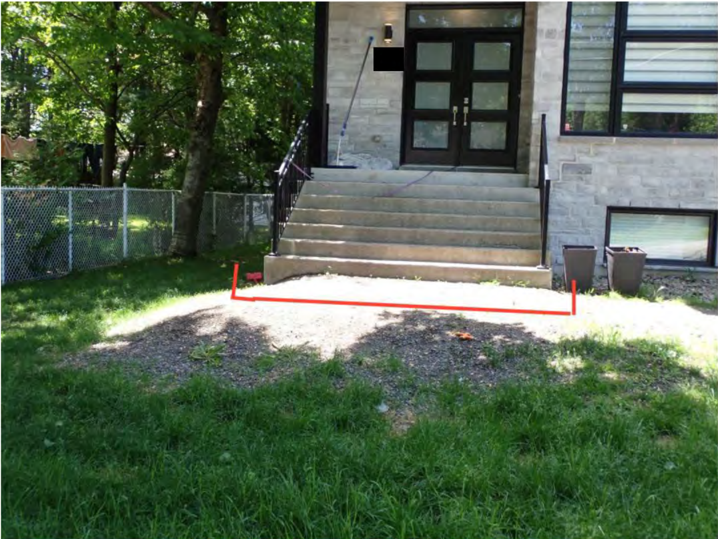
Zone à excaver - Installation de panneaux sous le sol en façade et de chaque côté
