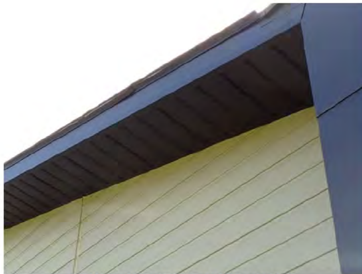
Aperçu du soffite existant noir (perforé)
