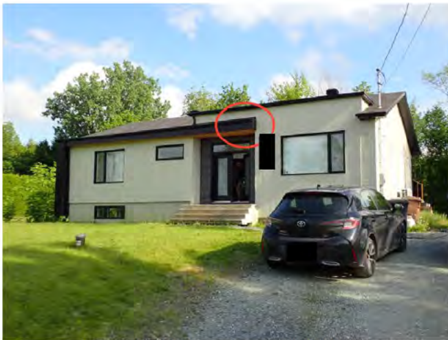
Localisation des travaux correctifs à la toiture
