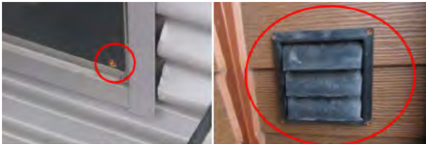
Illustration 119 et Illustration 120: Vis rouillées arrière 7105-5 et 7205-4
