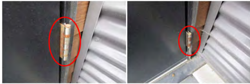
Illustration 171 et Illustration 172: Charnières rouillées 7105-5 <exemple>
