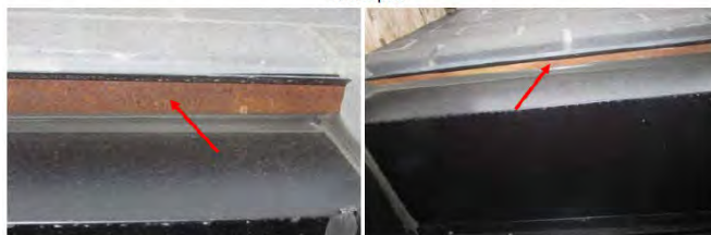
Illustration 113 et Illustration 114: Rouille observée aux linteaux d'acier gauche 7205 <exemple> extrait du rapport de l'expert
