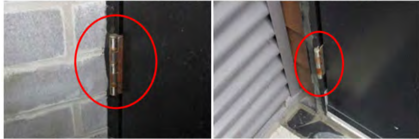
Illustration 173 et Illustration 174: Charnières rouillées 7205-5 <exemple> | extrait du rapport de l'expert
