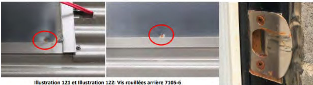
Illustration 121 et Illustration 122: Vis rouillées arrière 7105-6
