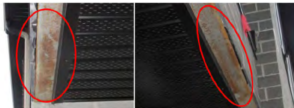
Illustration 111 et Illustration 112: Rouille observée aux linteaux d'acier avant 7105 et 7205 <exemple>
