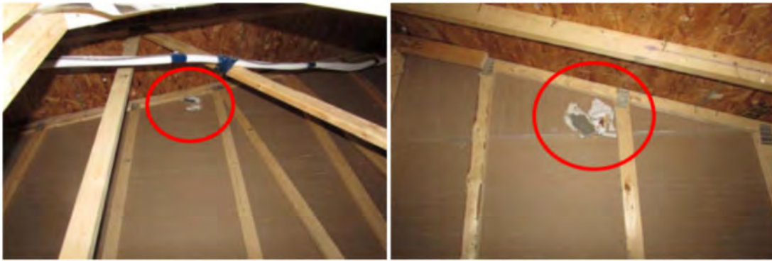
Illustration 268 et Illustration 269: Mur mitoyen non-retardant/non-étanche observé 7105-5
