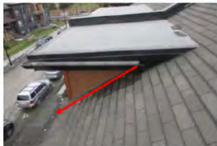
Illustration 217: Gouttière qui décharge sur le toit inférieur 7105-7205 <exemple>
