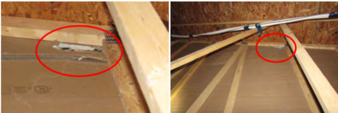
Illustration 272 et Illustration 273: Mur mitoyen non-retardant/non-étanche observé 7105-6
