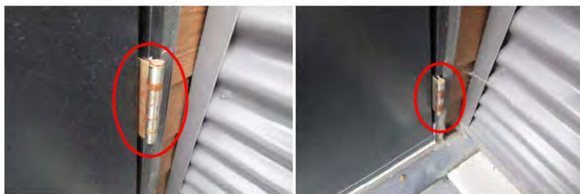
Illustration 171 et Illustration 172: Charnières rouillées 7105-5 <exemple>
