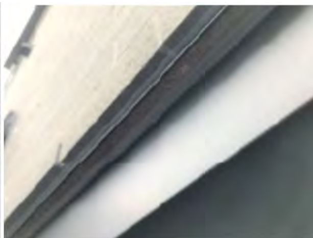
Illustration 113 et Illustration 114: Rouille observée aux linteaux d'acier gauche 7205 <exemple> extrait du rapport de l'expert
