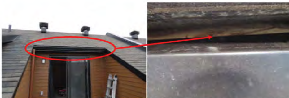
Illustration 199 et Illustration 200: Sous-toit à découvert arrière 7305-4 <exemple>
