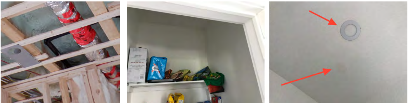
Photo durant la construction
