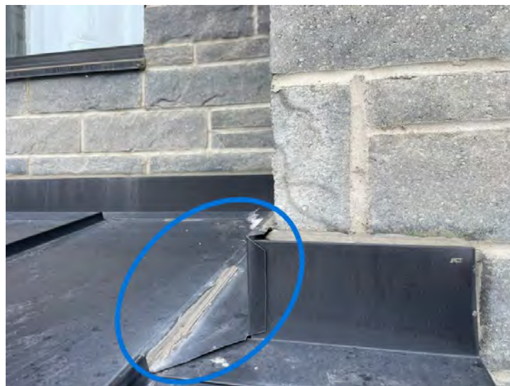
CONTRE SOLIN NON ÉTANCHE AU TOIT DE L'ENTRÉE AVANT
