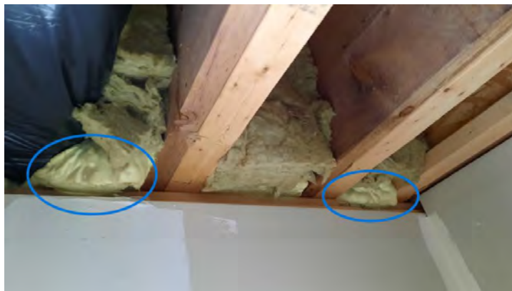
ISOLANT POLYURÉTHANE EXPOSÉ AUX RIVES DE PLANCHER RDC
