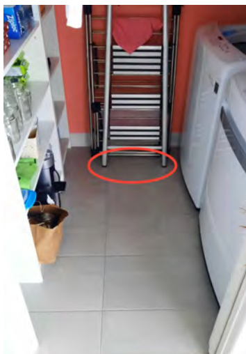
Emplacement de la nouvelle sortie de ventilation salle de lavage
