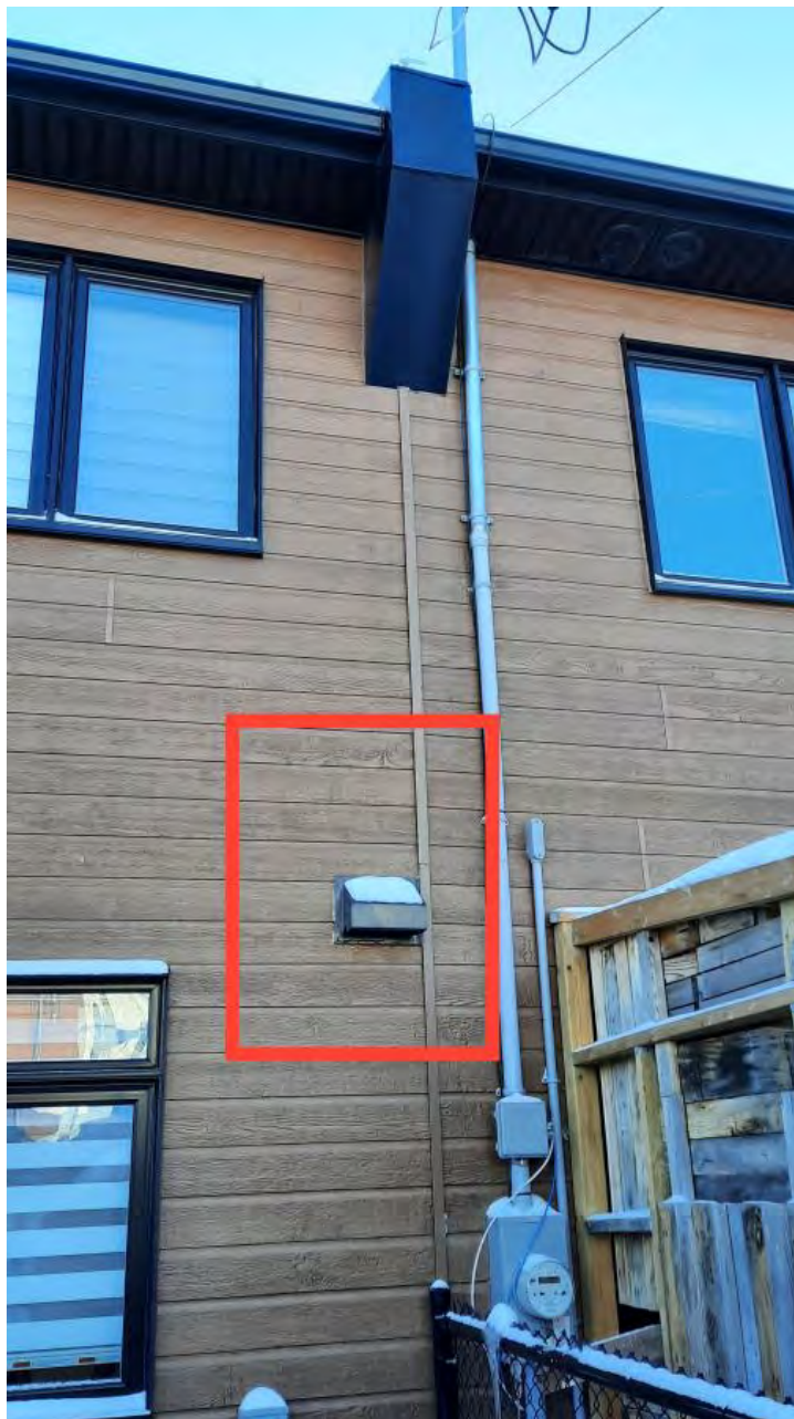
Portion du mur extérieur à dégager approximativement
