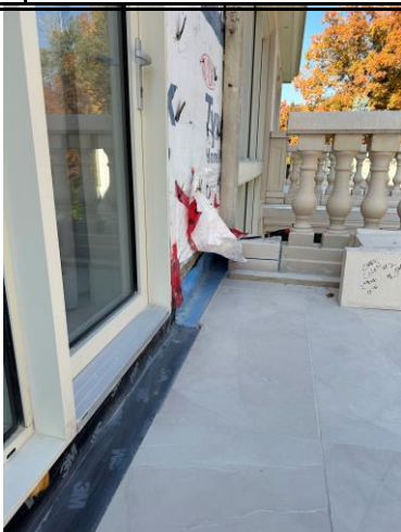
Garde-corp du balcon du 2e étage
