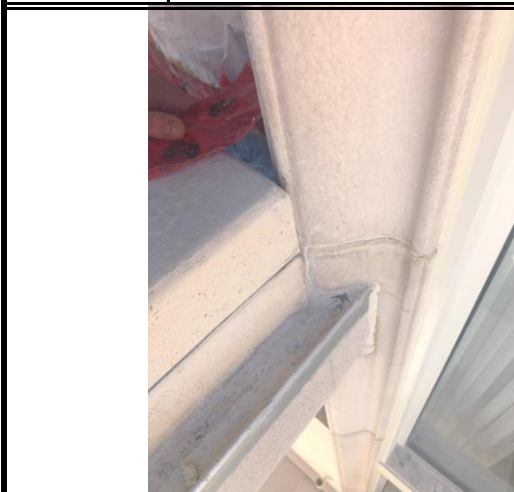
Rive gauche du balcon (vue arriere)
