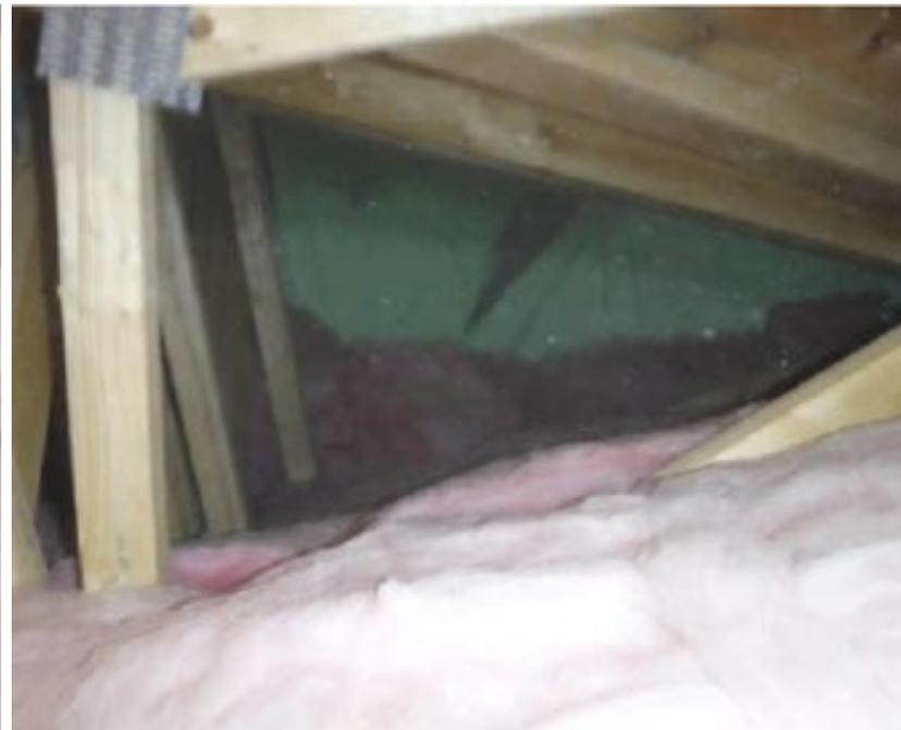
2. Vue du mur mitoyen – uréthane giclé sur blocs
