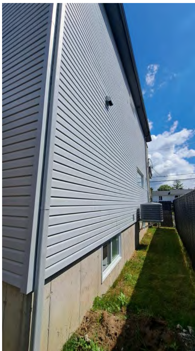
Vue complète du mur extérieur gauche en déclin de vinyle
