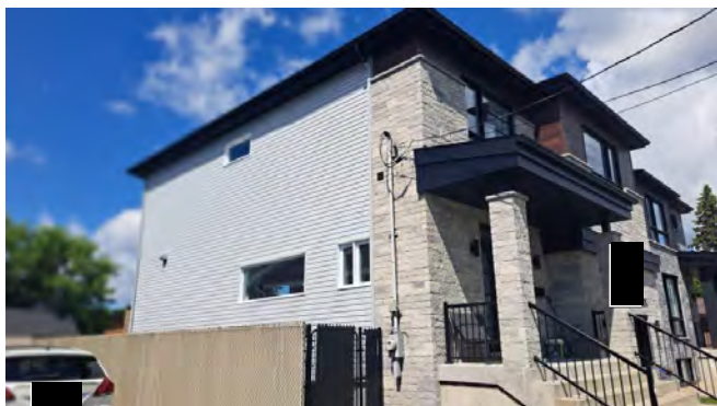
Vue complète du mur extérieur gauche en déclin de vinyle
