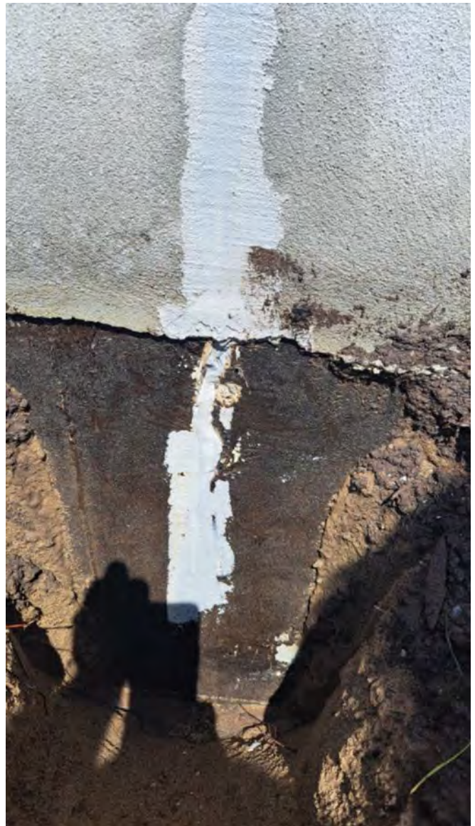
Photo témoin point # 1.3.3
