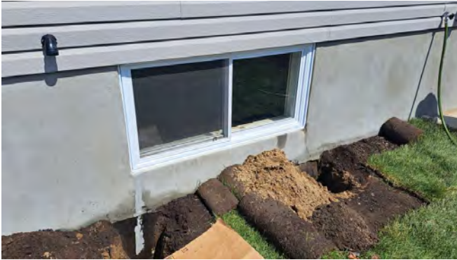
Photo témoin point # 1.3.3
