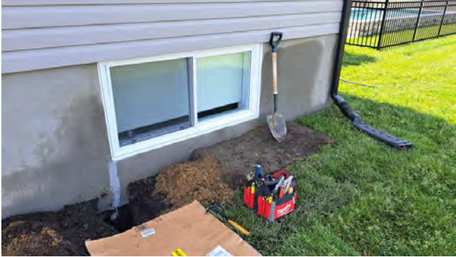
Photo témoin point # 1.3.3
