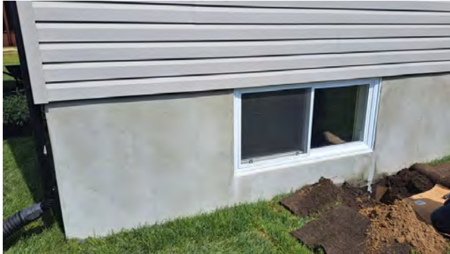
Photo témoin point # 1.3.2
