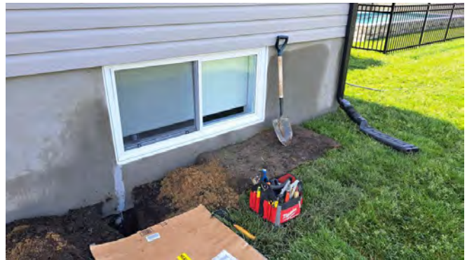
Photo témoin point # 1.3.1
