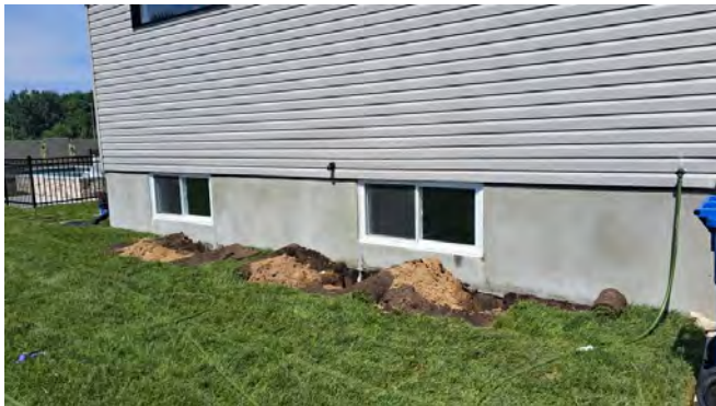
Photo témoin point # 1.3.1
