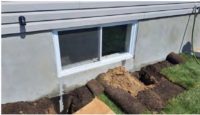
Photo témoin point # 1.3.4
