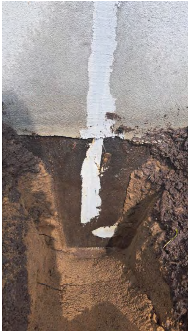
Photo témoin point # 1.3.2
