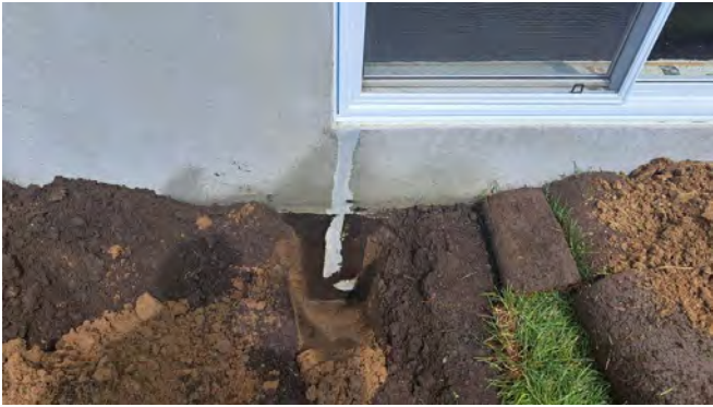
Photo témoin point # 1.3.2
