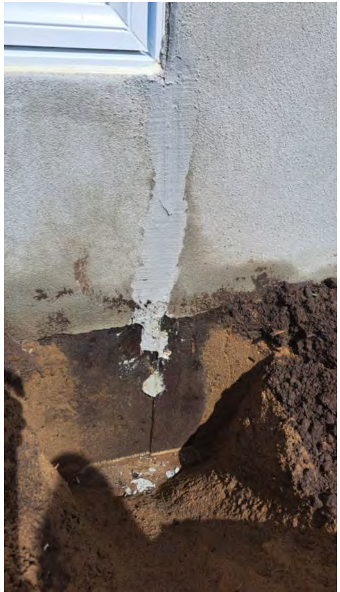
Photo témoin point # 1.3.2
