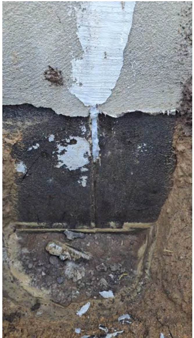
Photo témoin point # 1.3.3
