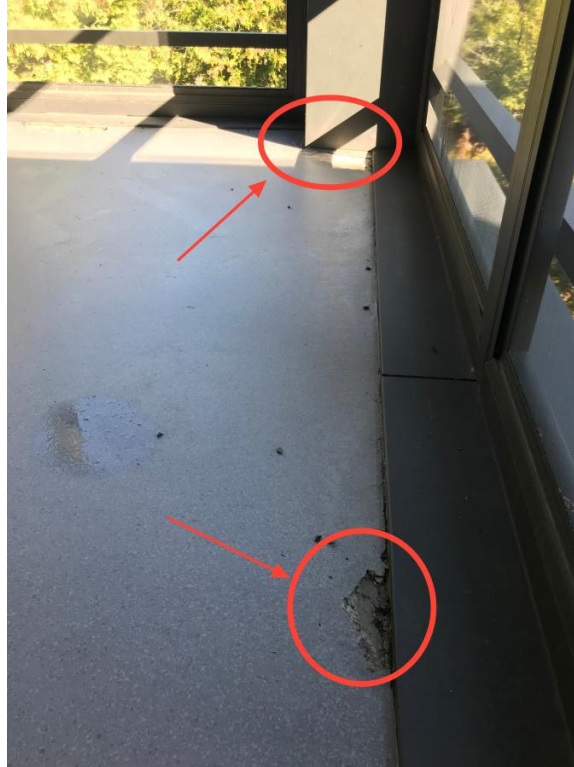
Photo #5 - Portions de béton endommagées devant être réparé.
