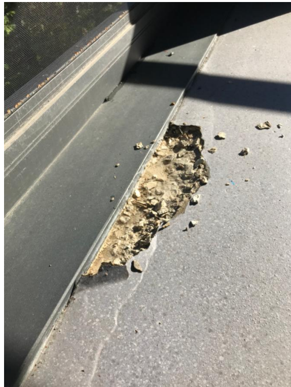
Photo #5 - Portions de béton endommagées devant être réparé.
