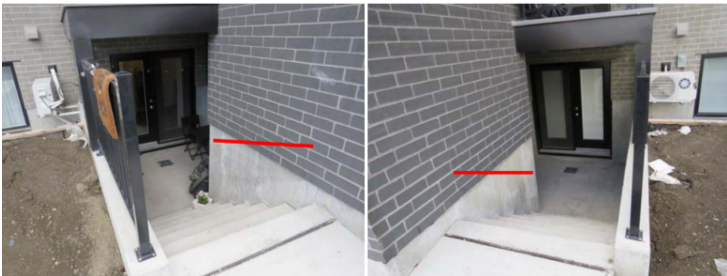
Main courante manquante à plusieurs endroits
