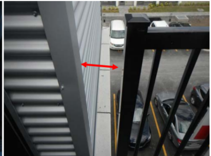
Espacement non conforme
