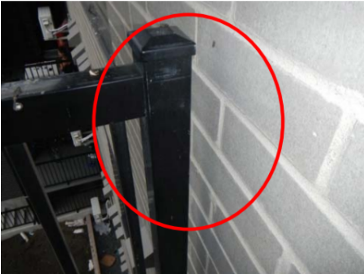
Mauvaise fixation
