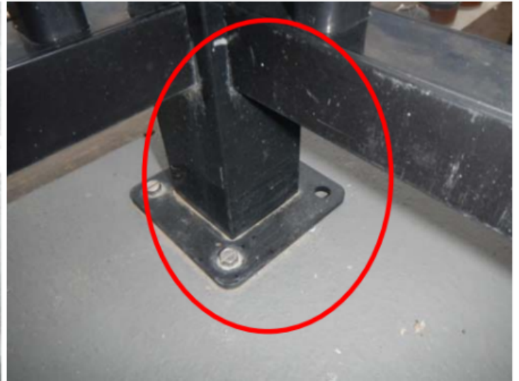
Mauvaise fixation
