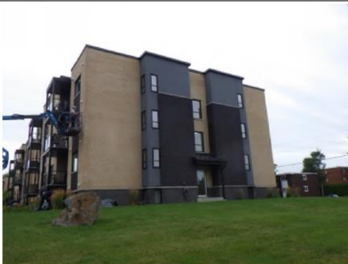
Photo 94 : Vue générale de la façade gauche.
