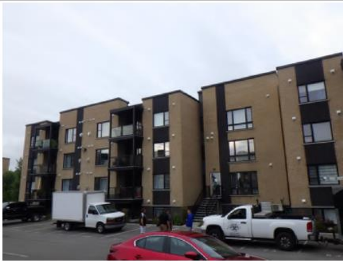
Photo 93 : Vue générale de la façade arrière.
