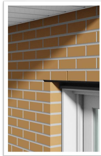
Source : GCR FT-9.27.3.8. – 01, Pose des solins - solins au-dessus des ouvertures
