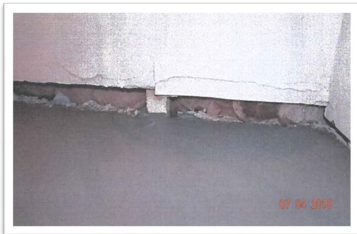
**Fourrures des murs extérieurs en contact direct avec le béton**
