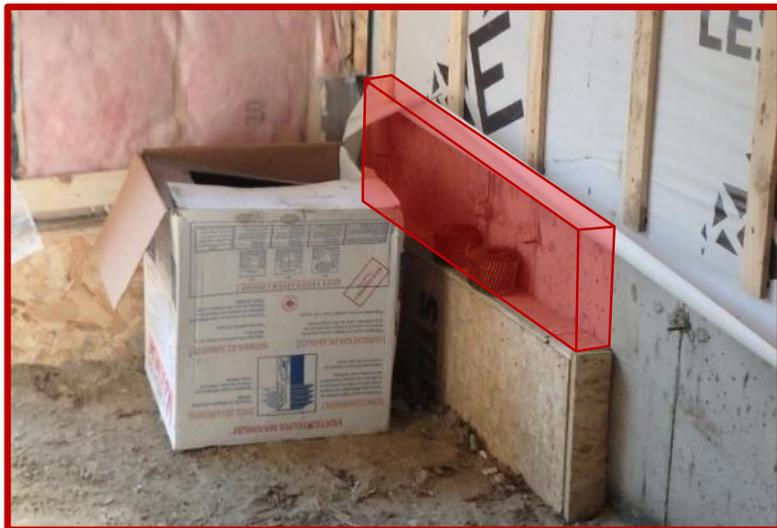
**Non-conformité relevée au chantier :** Isolation incomplète du mur mitoyen entre le garage et le bâtiment
